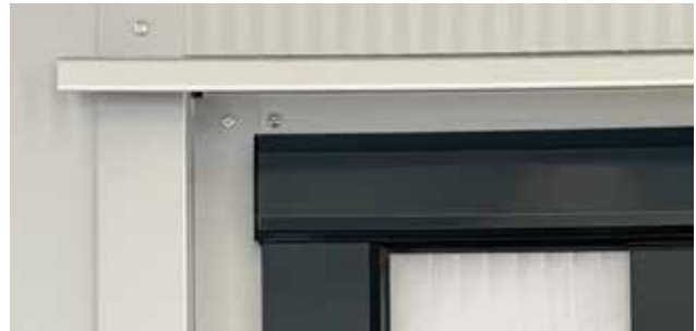
Abgedichtete Ecke oben
