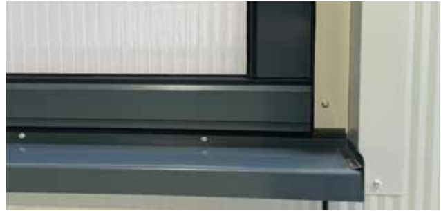
Abgedichtete Ecke unten
