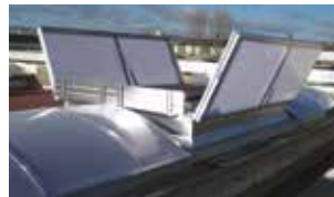
Rehausse dans voûte
